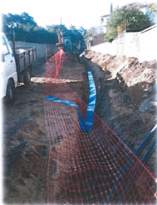
Figura n.º 12 – Instalação conduta de água
