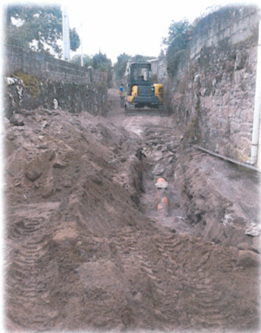
Figura n.º 3 – Instalação de coletor residual
