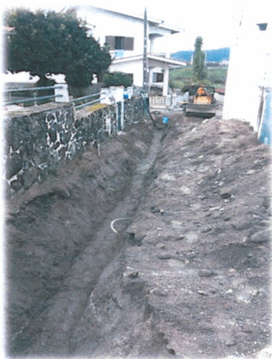
Figura n.º 14 – Instalação da rede de água
