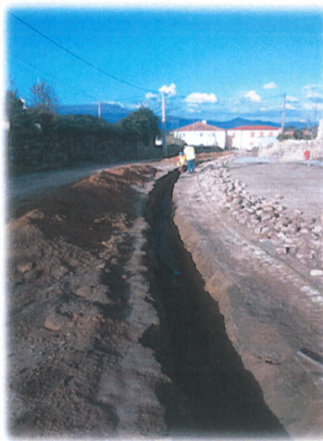
Figura n.º 11 – Instalação de conduta de água
