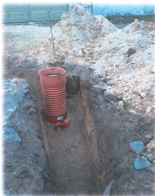
Figura n.º 13 – Instalação de caixa de ramal saneamento
