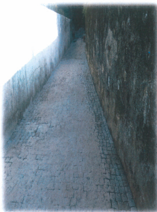
Figura n.º 15 – Trabalhos de pavimentação em cubo
