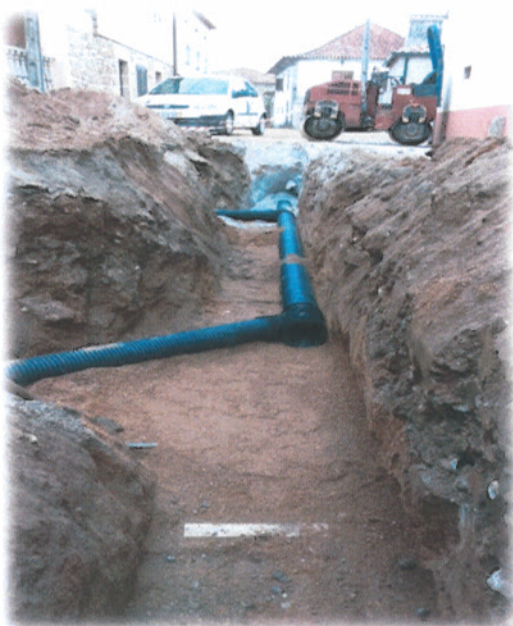
Figura n.º 10 – Instalação de coletor de saneamento
